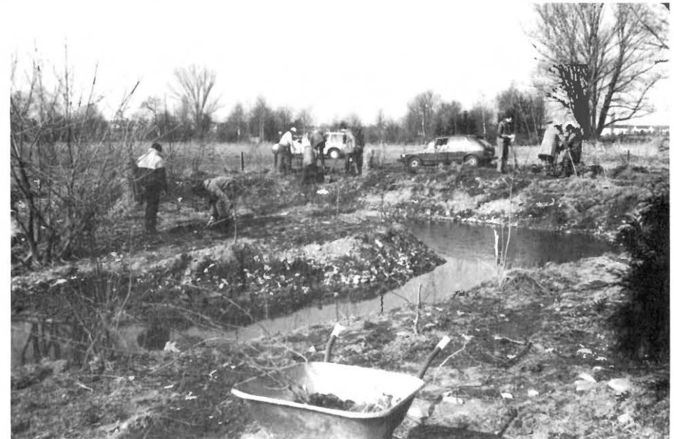
Arbeitseinsatz beim Anlegen des Biotops am großen Baggersee
